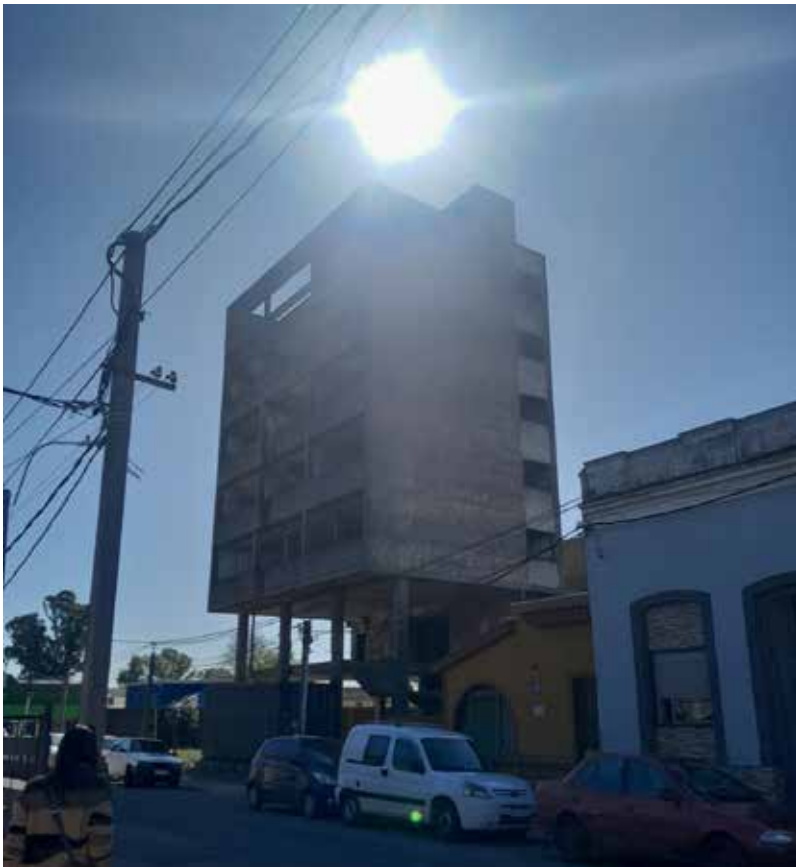
Local de la Unión Ferroviaria sin culminar.
