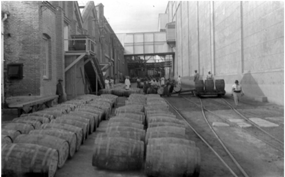
Instalaciones del frigorífico Anglo, calles internas donde se transportaban productos varios para el embarque, década del treinta.
