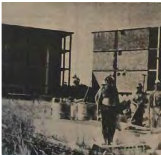
Construcción de viviendas por el sistema de ayuda mutua en cooperativa de Fucvam.
