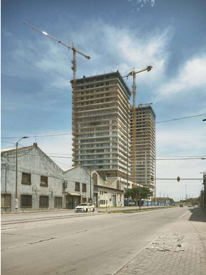
Torres en construcción, 2025. Fotografía de Santiago Medero.
