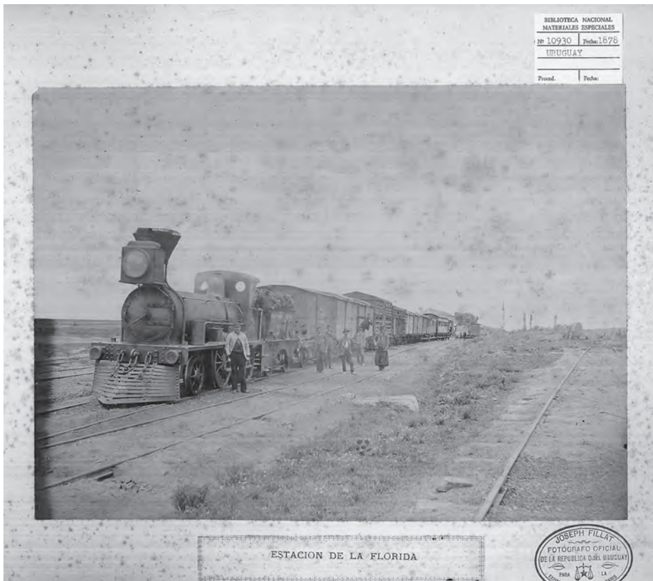
Figura 2. Estación de La Florida
