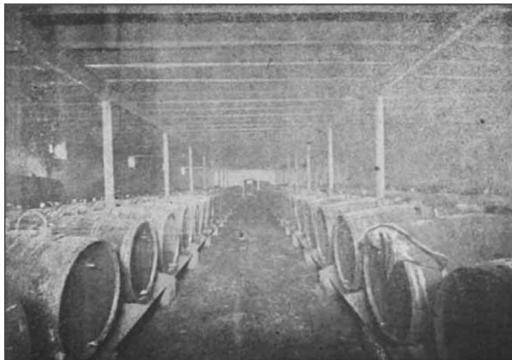
Figura 2. Vista interior de la bodega de Harriague
