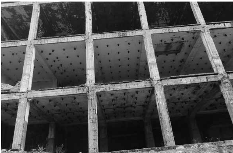
Fotos 3 y 4. Las estructuras fabriles que aún quedan en el barrio
