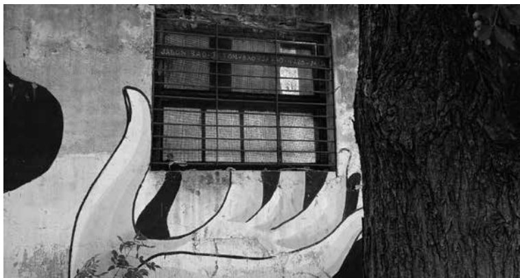
Foto 2. El edificio de la fábrica Bao en la actualidad
